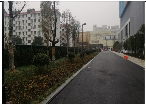
项目道路沿线雨水井及绿化
