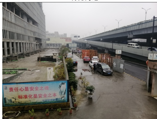
施工期临时绿化、施工区生活区隔离
