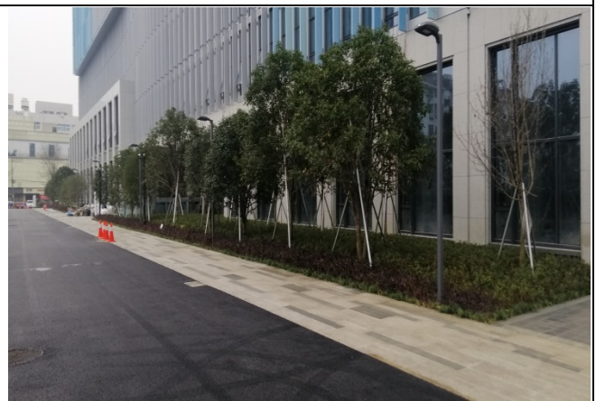
项目道路沿线雨水井及绿化
