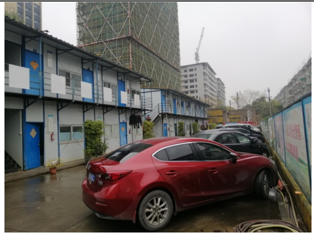
施工管理用房
